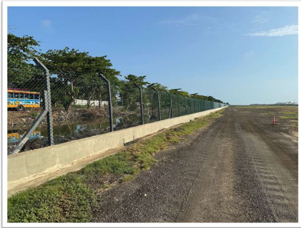
Ilustración 13. Ubicación del área de análisis – Deflector Aeropuerto Internacional Rafael Núñez. Fuente: Aerocivi
